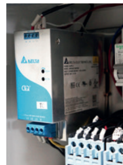
Cabina di controllo · Tensione di comando 24 Volt CC · Componentistica Siemens o Schneider
